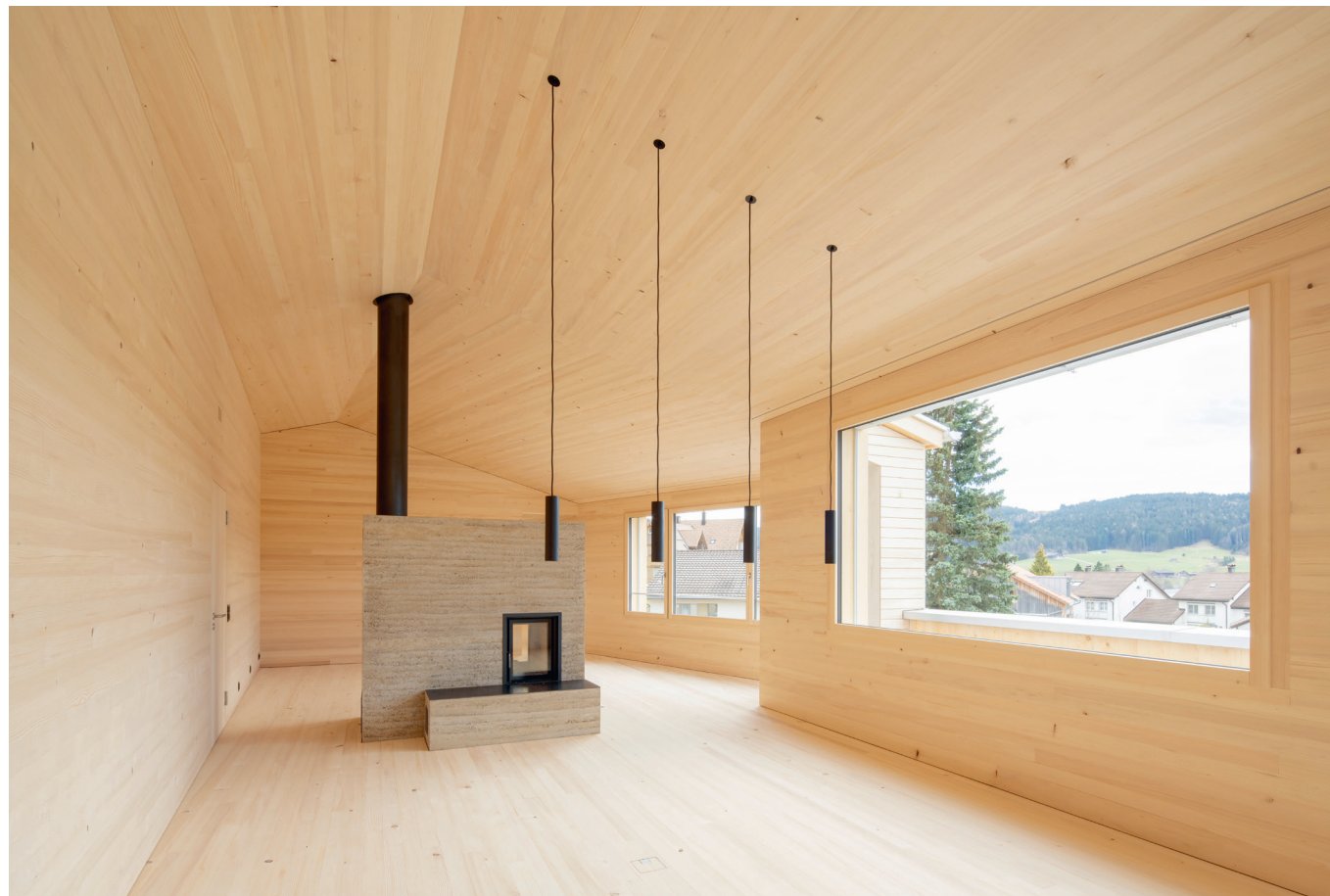
Das Haus am Hang öffnet sich zur Südseite, mit Blick über das Appenzellerland. Mit dem Stampflehmofen wird an besonders kalten Wintertagen geheizt.
