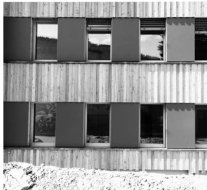
Holz, Farbe und Glas an der Südfassade.
