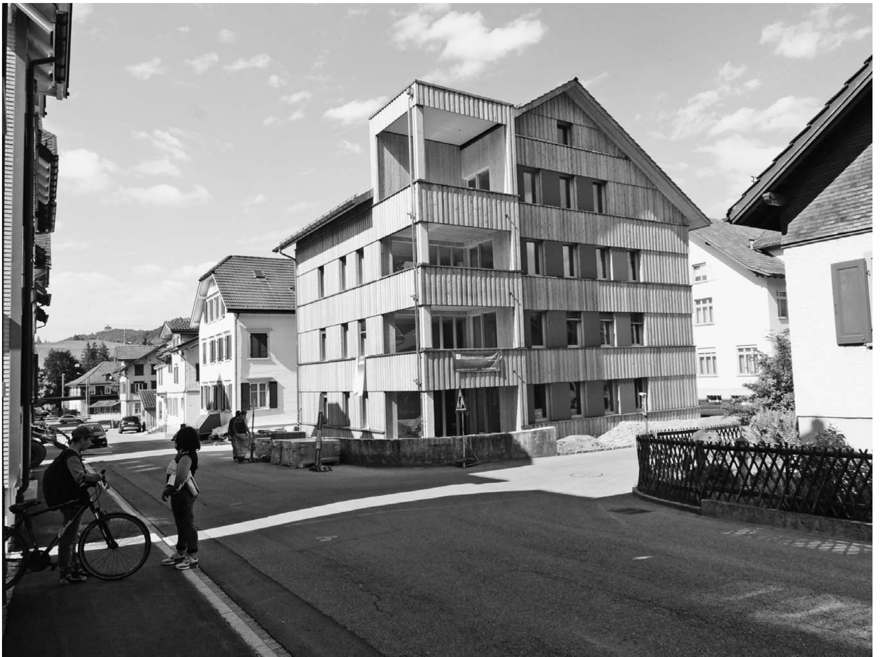
Das Haus Bahnhofstrasse 13 wirkt von Süden her imposant. Trotzdem fügt es sich gut in die Gesamtsituation ein.
